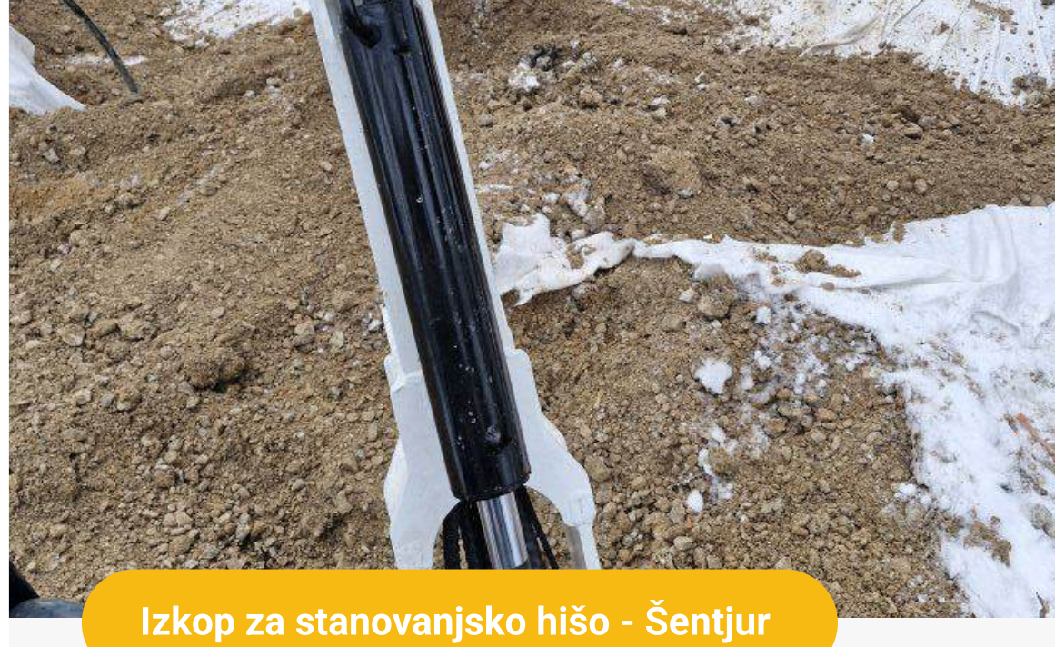
Izkop za stanovanjsko hišo - Šentjur
