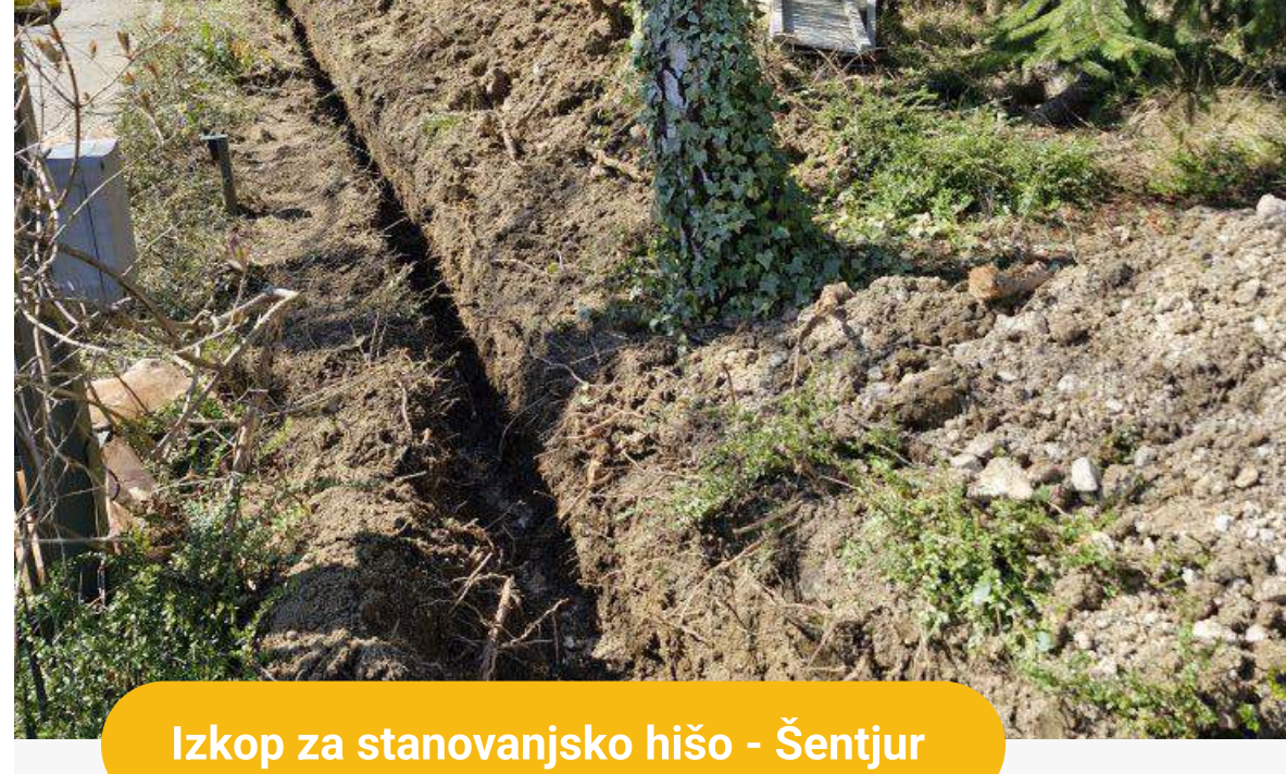
Izkop za stanovanjsko hišo - Šentjur
